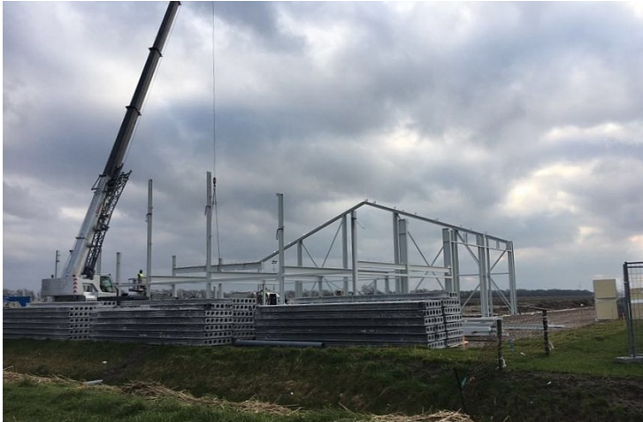
Foto Ronald Brockhus, 5 februari Het gebouw wordt 29 bij 76 meter
